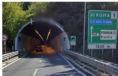
Imbocco Est-Direzione Bettolle
