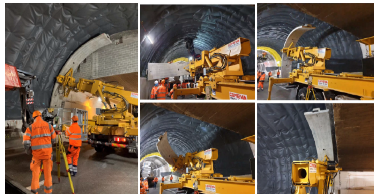
IMPERMEABILIZZAZIONE E POSIZIONAMENTO CONCI
