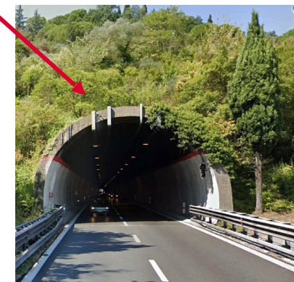
Uscita Ovest-Direzione Bettolle
